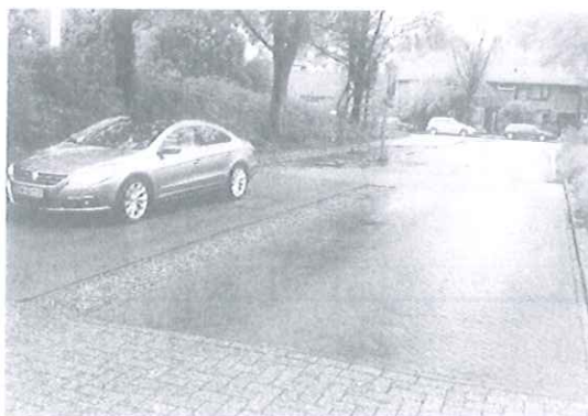
Rooftproject met een kolkloze regenwaterafvoer.
