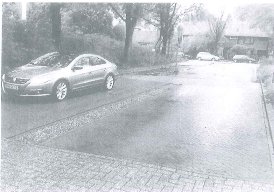
Proefproject met een kolkloze regenwaterafvoer.
